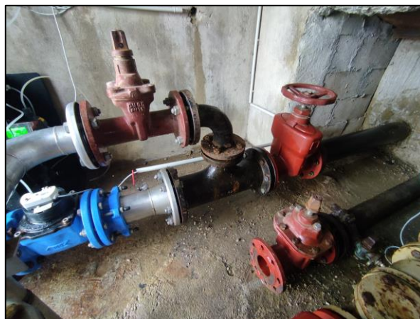
Conduite de distribution au réservoir d'Avrenay inférieur – Avant travaux
