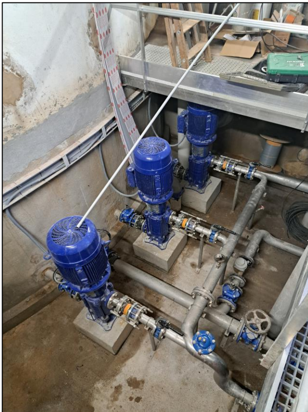
Chambre de vannes au réservoir de Sapins – Après travaux
