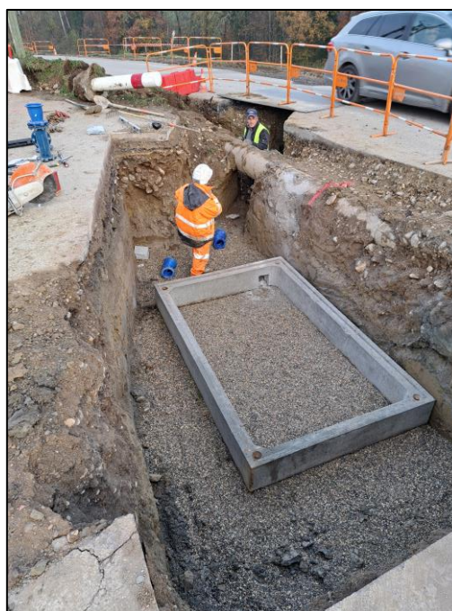
Pose d'une chambre de réduction de pression Renouvellement du réseau – Champfleury
