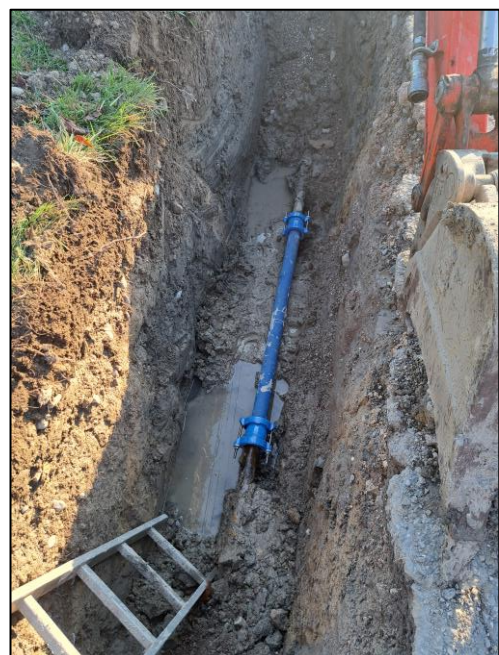
Fuite réparée sur le réseau de Champfleury, à Choisy
