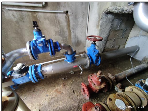
Conduite de distribution au réservoir d'Avrenay inférieur – Après travaux
