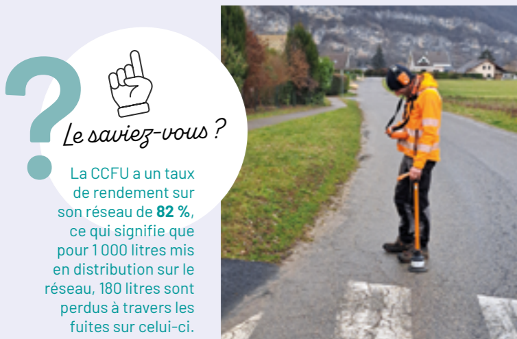
Recherche de fuite par un technicien de la CCFU équipé d'un détecteur électro-acoustique « aquaphon » qui permet d'identifier les fuites par l'écoute.
